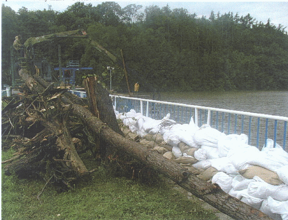
Zpevnění koruny hráze – 14.8.2002
